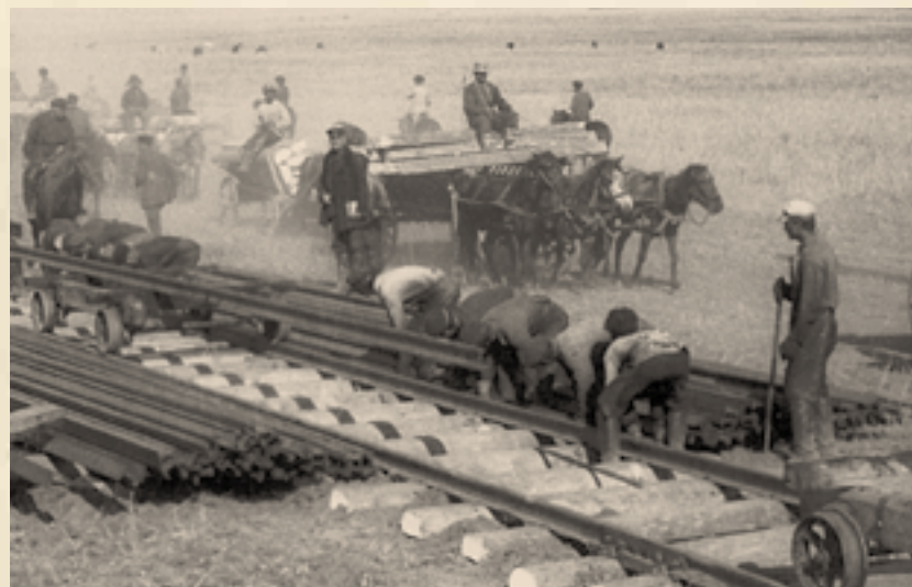
укладка рельсов на одном из участков строительства туркестано-сибирской железной дороги. 1927 год
