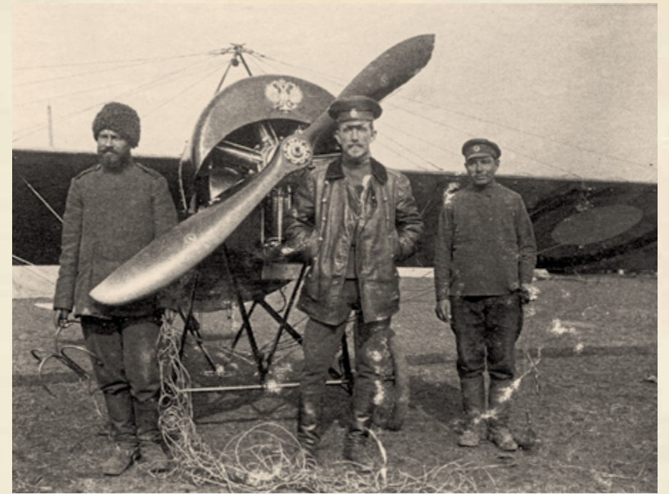
ПОРУЧИК АЛЕКСАНДР КОЗАКОВ С МЕХАНИКАМИ ОКОЛО САМОЛЕТА «МОРАН-СОЛНЬЕ ТИП G». В РУКАХ У МЕХАНИКА ОРУЖИЕ – ТРОС С ЯКОРЕМ И ГИРЕЙ. СЧИТАЛОСЬ, ЧТО, НАХОДЯСЬ В ВОЗДУХЕ НАД ПРОТИВНИКОМ, МОЖНО ЗАЦЕПИТЬ САМОЛЕТ ЯКОРЕМ ИЛИ ОПУТАТЬ ТРОСОМ ЕГО ВИНТ. 1915 ГОД
