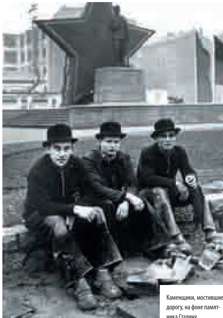
Рабочие на стройке в районе Сталиналле
